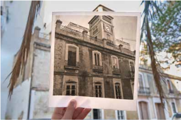
IMAGEN DE LA ANTIGUA FACHADA DE LA IMPRENTA VILA SOBRE LA RECIÉN RESTAURADA > Fotos D.R.
